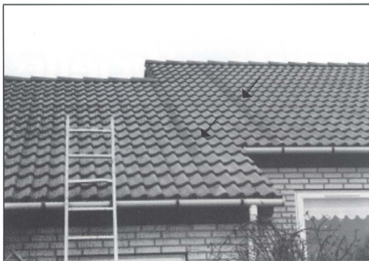
Tegltaget med de to mørke striber, hvorfra der blev opsamlet analyseprøver.
